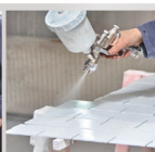
TRAVAUX DE PEINTURE
