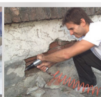
TRAVAUX DE CHANTIER
